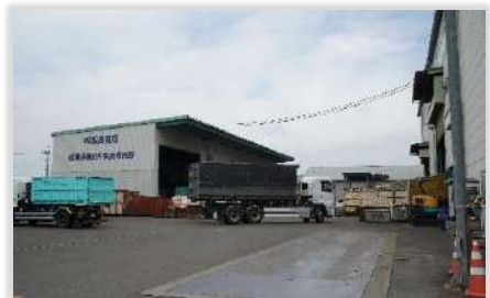
産業廃棄物中間処理工場
