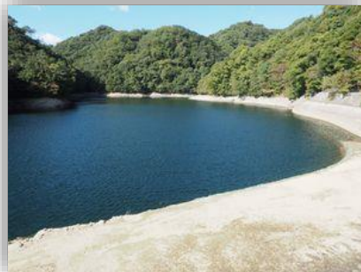
五本松堰堤(布引ダム)
